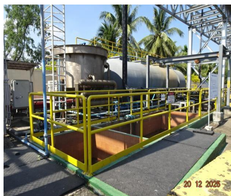
ภาพที่ 2-9 บ่อดักคราบน้ำมัน (Oil interceptor)
