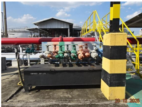
ภาพที่ 2-3 ถาดรองรับน้ำมันที่อาจรั่วไหลจากการถอดและข้อต่อในการขนถ่ายน้ำมันที่ท่าเรือ
