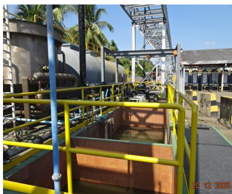
ภาพที่ 2-9 บ่อดักคราบน้ำมัน (Oil interceptor)
