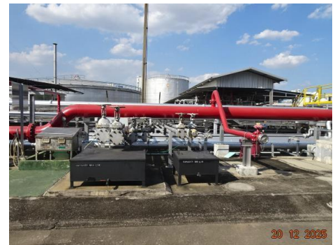
ภาพที่ 2-3 ถาดรองรับน้ำมันที่อาจรั่วไหลจากการถอดและข้อต่อในการขนถ่ายน้ำมันที่ท่าเรือ
